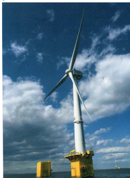
写真1 福島県楢葉沖の浮体式洋上風車 (手前が2016年運開の7MW風車、 右奥が2013年運開の2MW風車)
