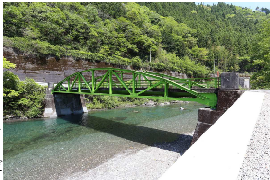
写真4 日ノ出橋(高知県)
