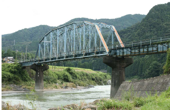
写真1 長良川鉄道第五長良川橋梁(岐阜県)
