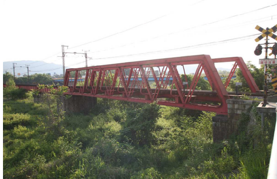
写真2 近江鉄道愛知川橋梁(滋賀県)
