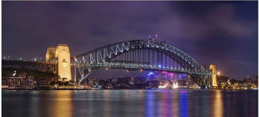
ハーバー・ブリッジ(シドニー)
