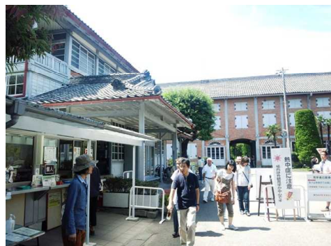
写真1 正門より検査人館と東繭倉庫を臨む
