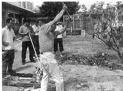
写真1 三本鍬を使って土を掘り起こす
