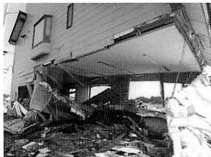
写真1 津波で一階が壊れた家(福島県新地町)
