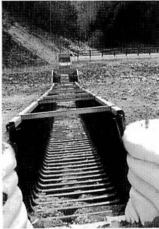
写真4 土捨て場の大沢川に伸びる排水溝
