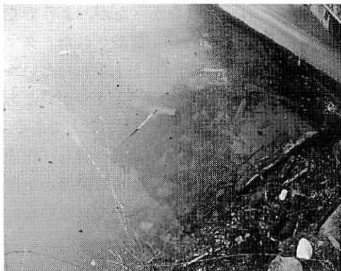
写真2 品木ダム堤際の堆積した汚泥
