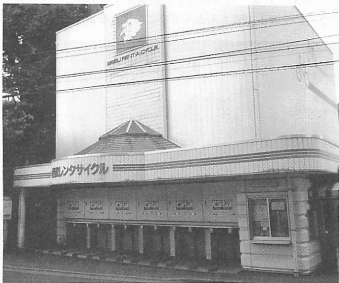
写真1 レンタサイクル立体機械式駐輪場
