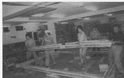
刻んだ丸太（梁）を運ぶ研修生
