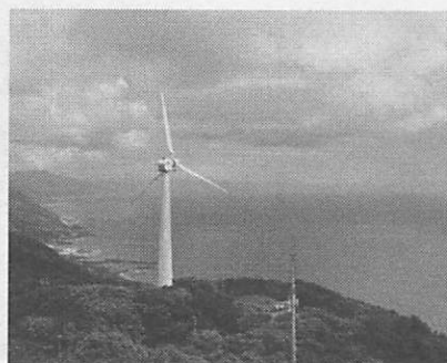
写真2 室戸風力発電所
