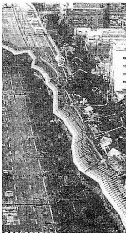
写真1 地震による高速道路の倒壊現場（これが実像の世界）
