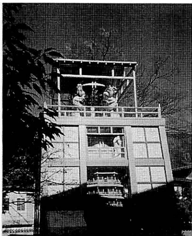
写真1 水運儀象台の外観
