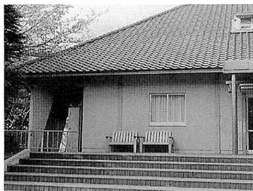
写真4 建物にマッチしたベンチ
