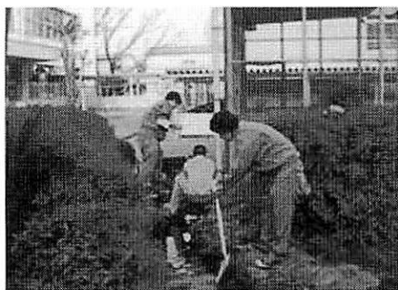
水路の清掃風景
