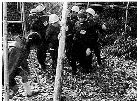
写真2 掘って立て柱を立てる
