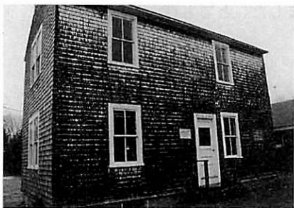
写真1 海岸より移設した海岸無線局 (1907年) 現存する最古の局
