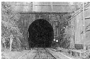
写真6 木戸山トンネル
