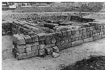
写真4 新橋停車場基礎
