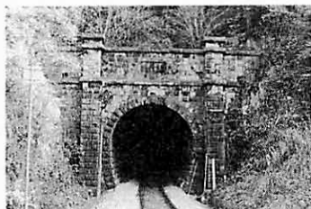
写真1 大草トンネル
