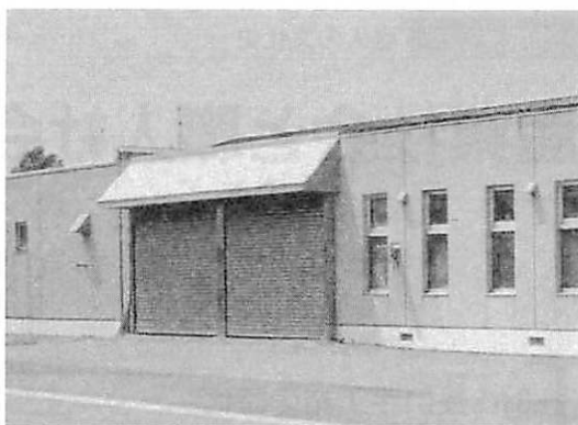
写真3 完成したばかりの工場
