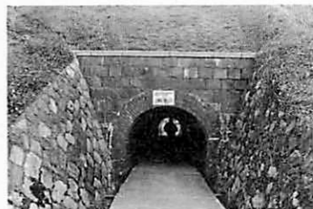
写真2 立野第二橋梁
