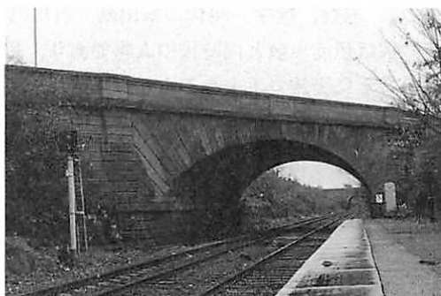
写真5 レインヒル跨線陸橋
