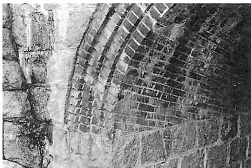
写真4 甲大門西橋梁の内部
