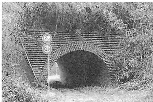
写真2 奥ヶ谷池橋梁
