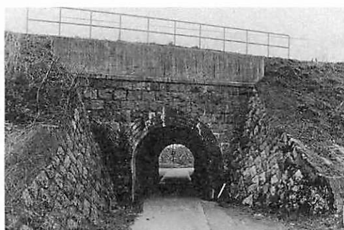
写真3 甲大門西橋梁
