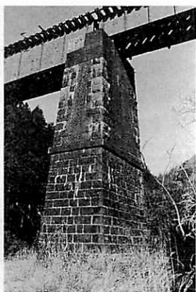
写真8 屋洲川橋梁の橋脚
