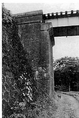
写真2 小国川橋梁の橋台
