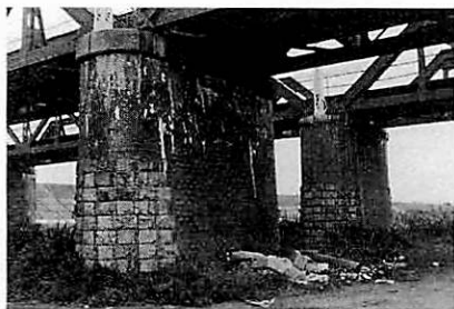
写真5 長良川橋梁の橋脚
