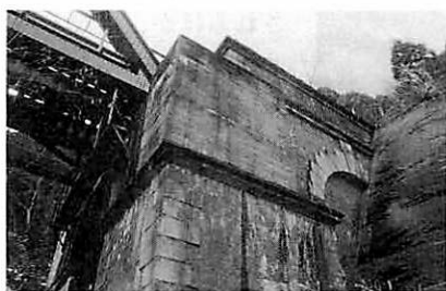
写真1 保津川橋梁の橋台
