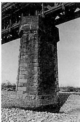
写真7 宮川橋梁の橋脚
