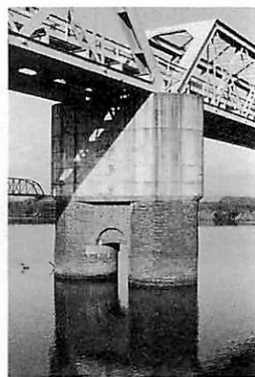
写真4 旧・損斐川橋梁の橋脚
