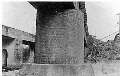
写真3 清江橋梁の橋脚
