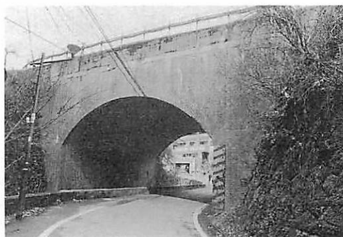
写真2 欠円アーチ断面を用いた第二浅川橋梁
