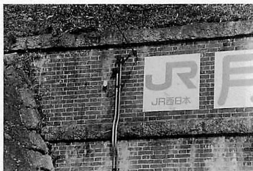
写真3 伊賀街道架道橋に見られるフランス積み
