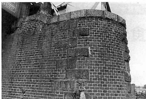
写真4 嘉麻川橋梁の橋脚に見られるイギリス積みと小口積み
