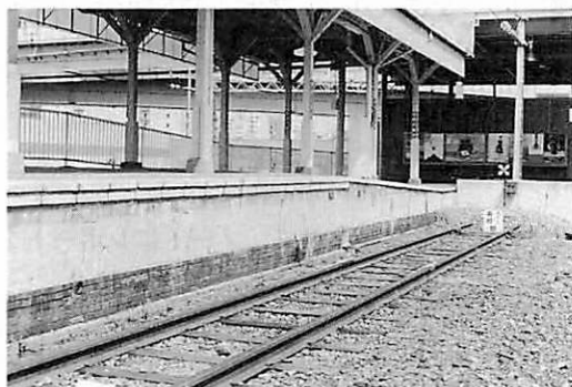
写真5 旧・湊町駅プラットホームの煉瓦積み基礎
