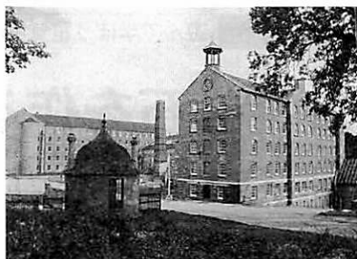
写真3 改修を待つStanley Mills西工場
