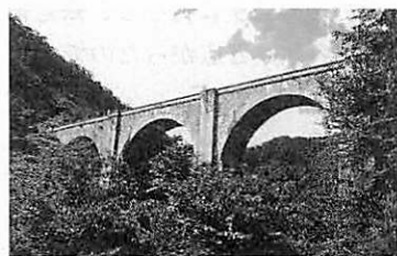
写真1 国指定の重要文化財となっている碓氷第三橋梁
