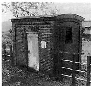
写真2 常磐線磐城太田駅のホームに残る油庫
