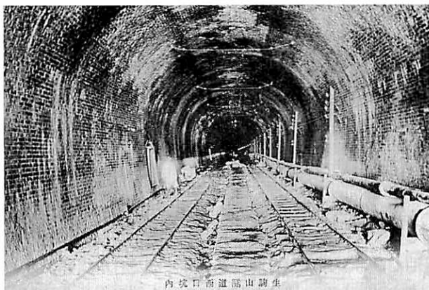
写真2 建設中の生駒トンネルの内部（絵ハガキより）
