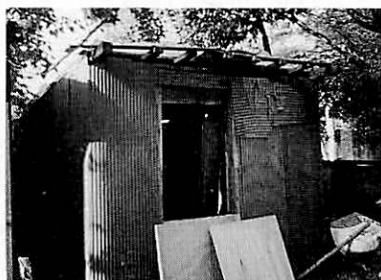
写真3 以前建てた木造倉庫も教材として再利用を検討中
