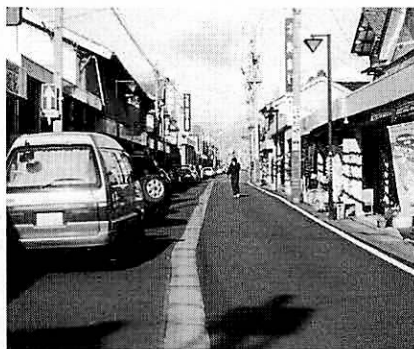
写真2 一方通行にして、駐車場
