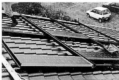
写真3 このモジュール60枚で 3kwの出力になります
