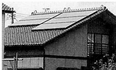
写真1 太陽光発電所「ピカリン」
