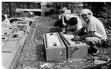
写真2 配線の接続をして、パネルを屋根に上げました。
