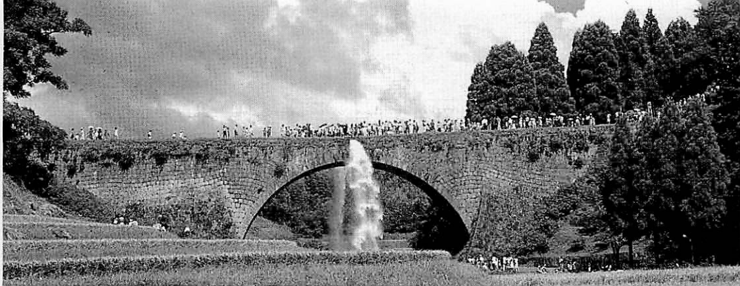
写真2 種山石工の傑作・通潤橋 (1854)。水は左岸からくんだり7m上の右岸へのぼる (熊本県観光パンフレットによる)
