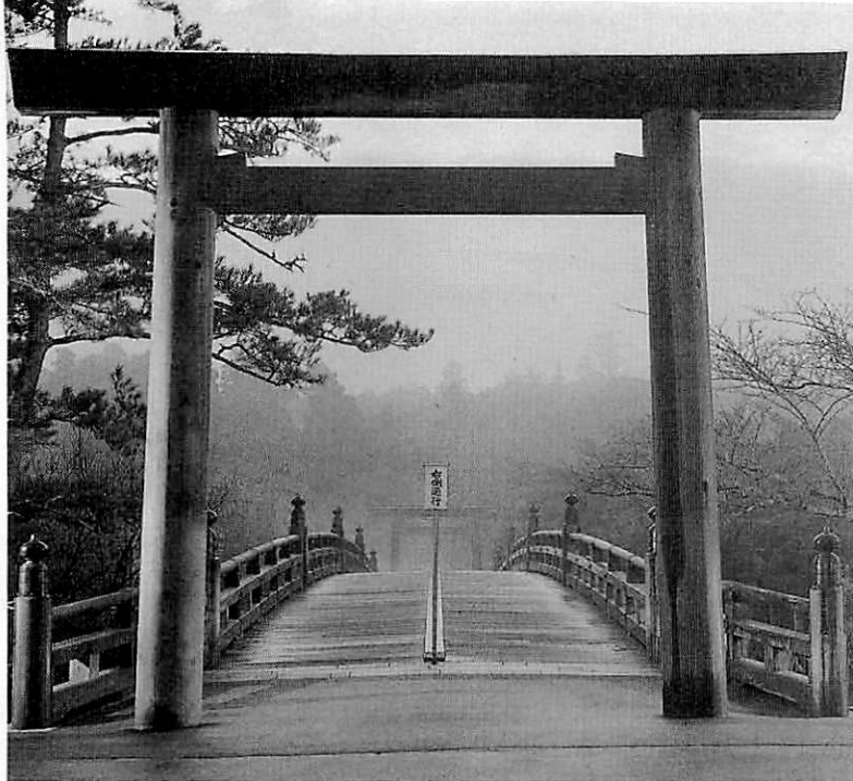
写真2 五十鈴川の清流を渡る伊勢神宮（内宮）の宇治橋 両側の鳥居はそれぞれ内宮、外宮の旧正殿の棟持柱を用い、ここでの使用を終えると他社へ転用され合計して60年間使用されるという。現橋は1989年製。（神宮司庁編・発行：「伊勢の神宮」による）
