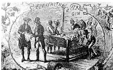
写真8 コットンジンによる綿繰り作業
