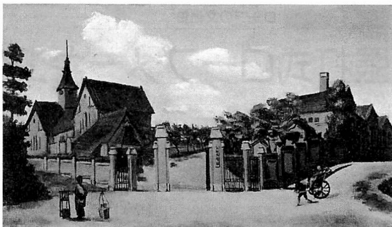
近代工学教育のあけぼの・工部大学校の油絵 場所は現在の千代田区霞ヶ関3丁目一帯で、文部省、会計検査院、霞ヶ関ビルに囲まれていた。 （提供：日本工学会）
