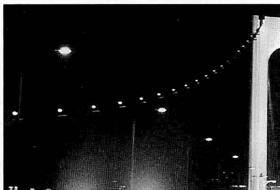
写真5 ケーブルイルミネーション(右は主塔、頂部に太陽電池設置)
