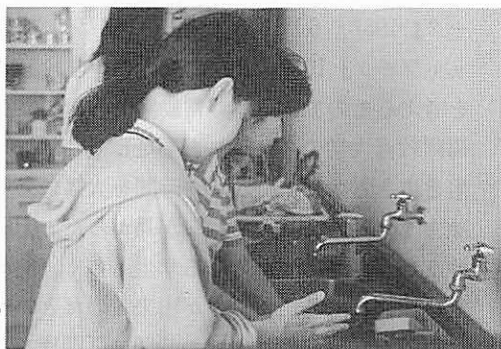
写真1 家庭管理演習室の蛇口の様子
