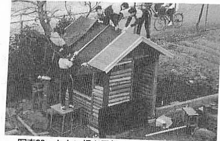
写真28 トタン板を屋根に張る
