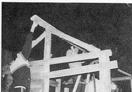
写真18 棟木が上がった瞬間
