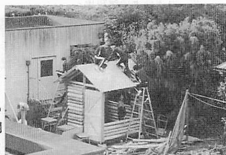
写真21 コンパネを屋根下地として張る
