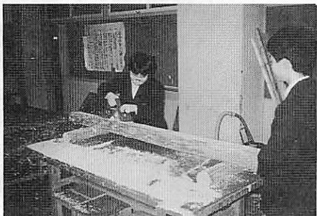
写真7 柱用丸太を電動かんなで削る
