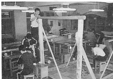
写真11 土台に柱を立て「はり」をのせる
