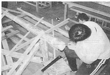
写真12 小屋組み（屋根の骨組み）を作る
