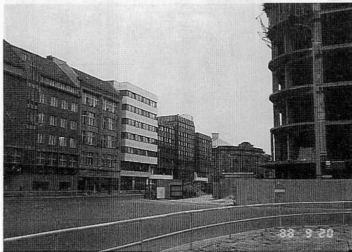
写真3 ライプツィガー通りの改修と再開発の様子
