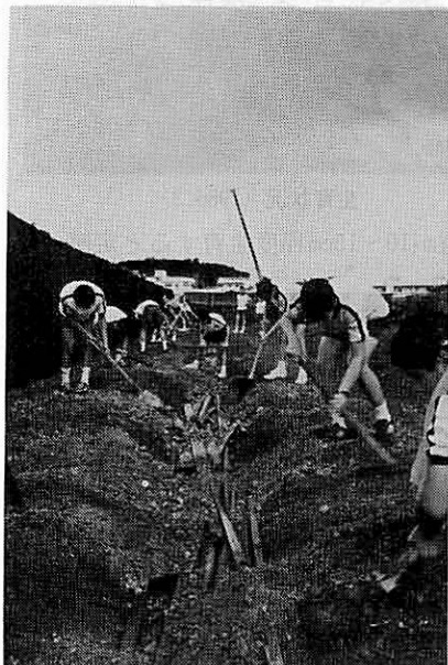
暗渠排水の設置作業
