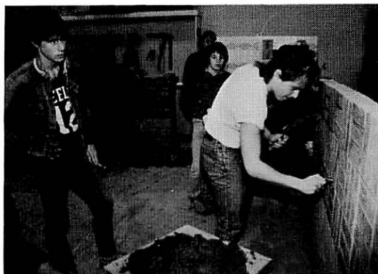
クレストウッド・セコンダリースクール Trowel trades room
