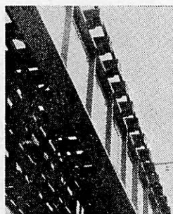
鉄橋は④の左側のものに もうすこし補強をしたも のです
