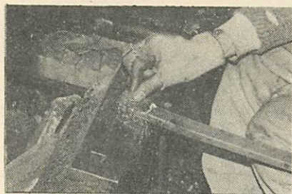
写真2 鍛接剤を付け刃金を乗せる 気温の低いときはいいけれど、夏場は工場用の大型扇風機を回してもまだ暑い。といってシャツをぬいで裸で仕事はできない。なにしろ真赤な火の粉が飛んで来る。
