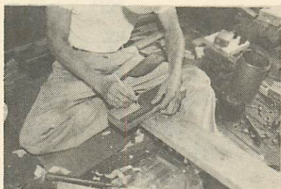
写真6 定規を使い寸法線の書き込み
