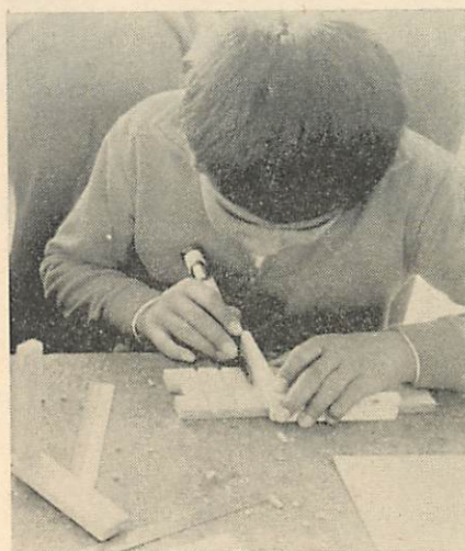
写真2 直角定規による安全作業
