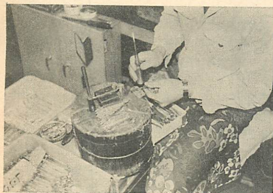
写真5 最後のビスじめをし、かしめる
