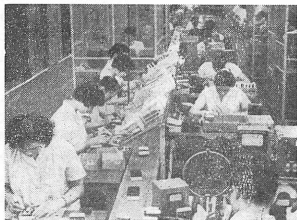
3図 トランジスタラジオの試験調整
